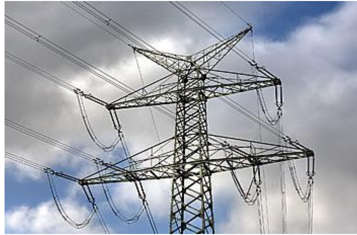
400-kV-Freileitung
