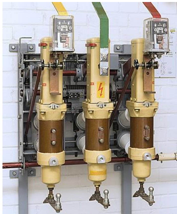
Leistungsschalter für 10 kV
